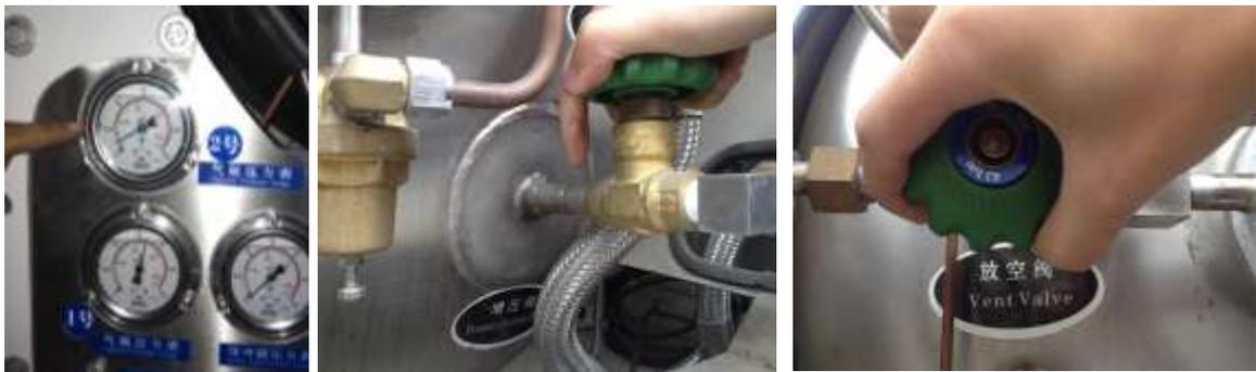
b、打开出液阀（见下图），同时检查管路系统是否泄漏。
